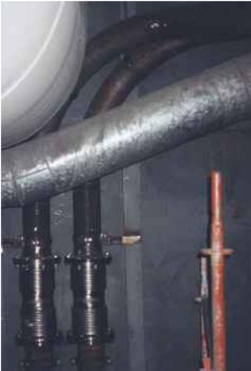
Bild 4: Kompensatoren in den vertikalen Förderleitungen
