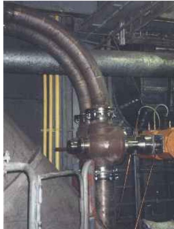
Bild 5: Einbindung der Förderleitungen in den TT-Rücklauf
