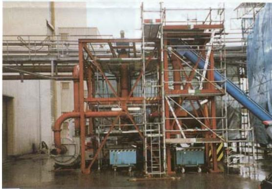
Im Kesselhaus, kurz vor der Kesselwand, wurde eine Zweifach-Verteilung in die Förderleitung eingebaut, welche den Materialstrom in 2 Einblasleitungen bzw. Düsen verzweigt. Unmittelbar vor dem Eintritt in den Kessel ist pro Einblusstelle eine Sperrluftereinblasung vorgesehen. Dadurch soll verhindert werden, daß sich bei abgeschalteter Holzförderung die Öffnungen in der Kesselwand zusetzen. Die Förderrohrleitungen bestehen aus dickwandigem Normalstahl.
